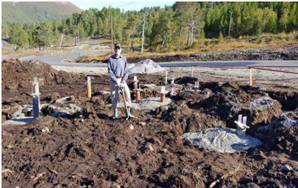
Primus motor Audun Nerland i gang med grunnarbeidet
