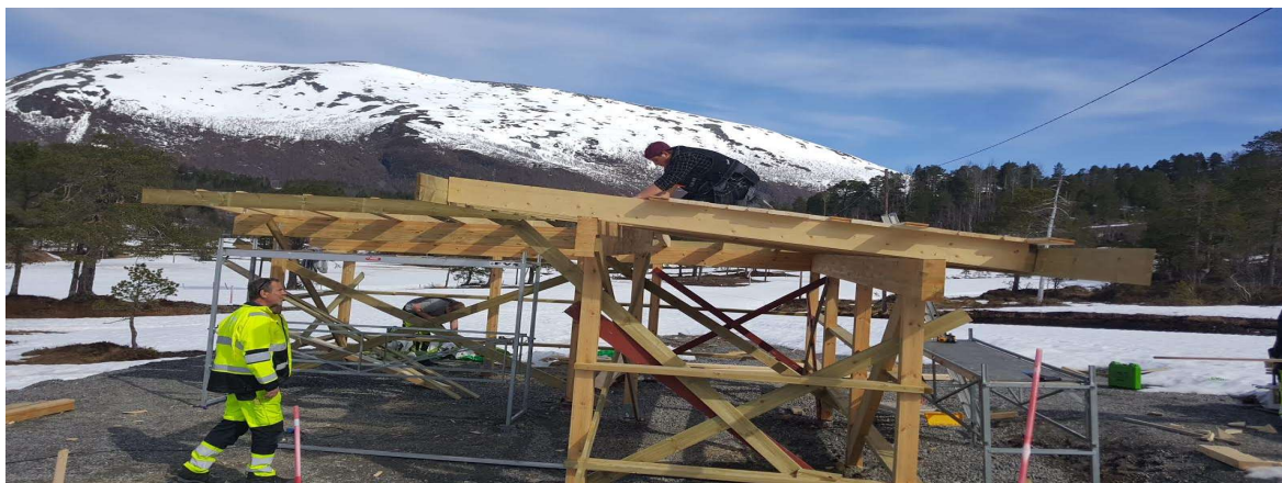
Fræna vidaregåande skole i full gang med reising av bygget
